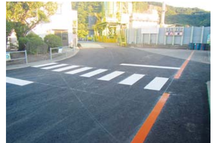
場内のECOフォームド舗装
